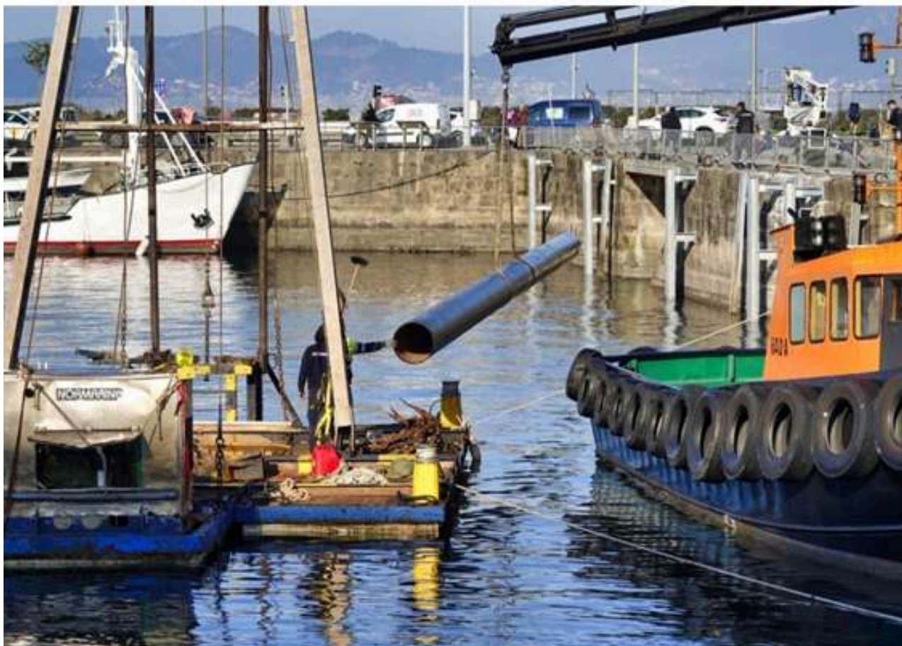
Comenzaron las obras de instalación de los nuevos pantalanes flotantes en la dársena de A Laxe del puerto vigués.
